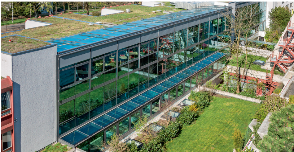
Die neue Fassade der Senioren-Appartements Egghölzli in Bern mit dem rund 90 Meter langen Laubengang besticht durch Harmonie, Zurückhaltung und modernste Technik. Bild: Andreas Frutig, Bern La nouvelle façade des appartements pour seniors Egghölzli à Berne avec sa coursive de quelque 90 m de long séduit par son harmonie, sa discrétion et sa technologie ultramoderne.
