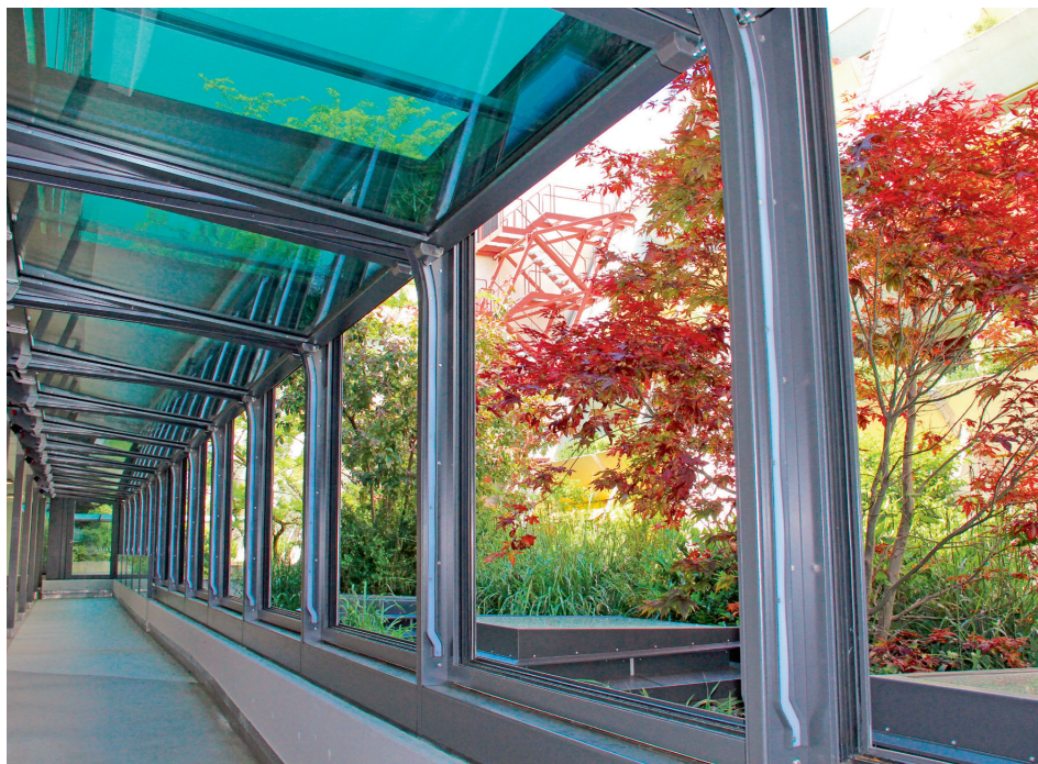
Anhand der Führungsschiene ist der Bewegungsverlauf des Flügels gut zu erkennen. La course du battant se repère aisément au moyen du rail de guidage.
